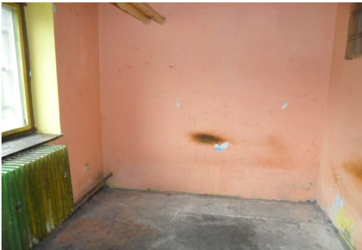
Sklad prádla a obuvi pred rekonštrukciou
