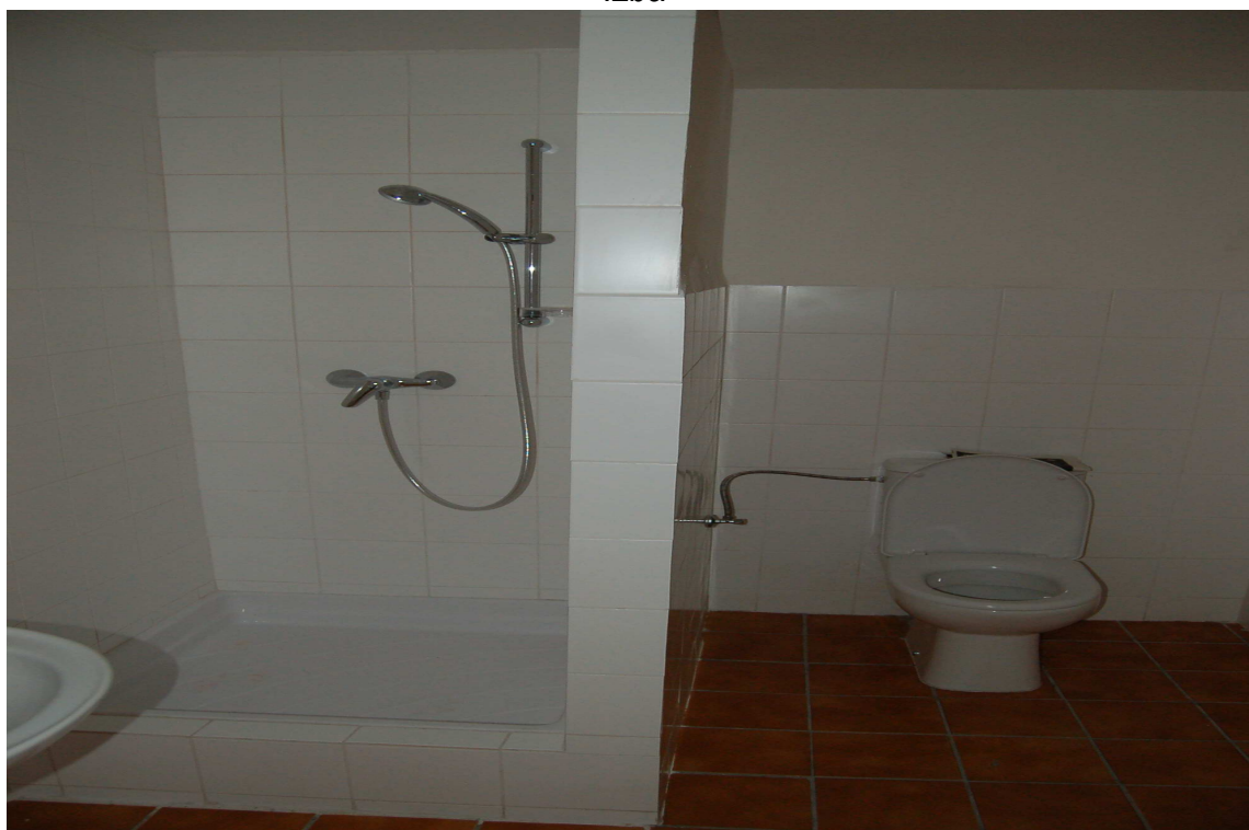
Kúpeľňa s WC
