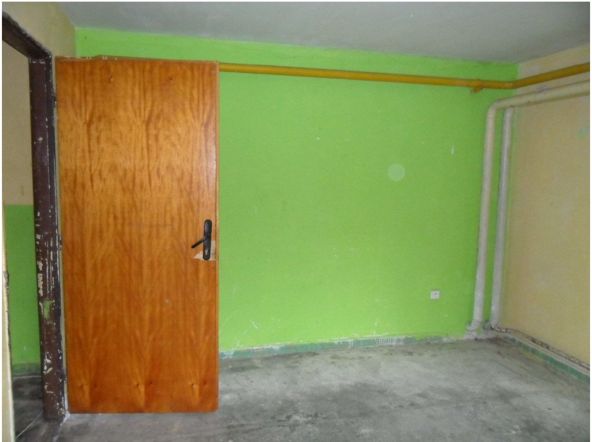
Sušiareň a žehliareň pred rekonštrukciou
